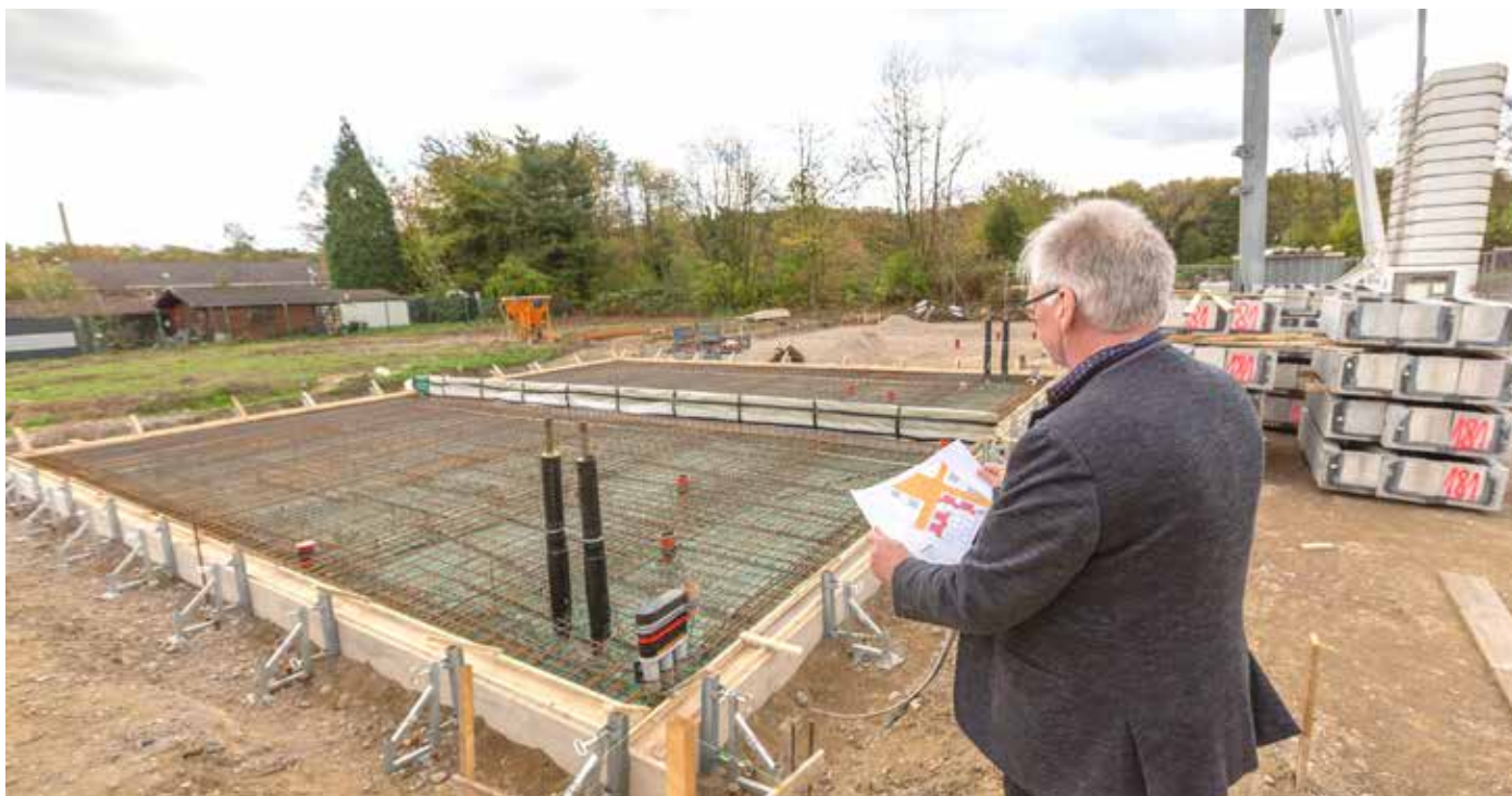
Bauleiter Ralf Hutmacher auf der Baustelle für die acht Doppelhaushälften. Zur Zeit werden die Bodenplatten gegossen. Die kleine Ansicht (unten) zeigt das Aussehen der Häuser.
